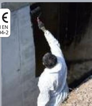
DERMARUBBER S/P es un impermeabilizante líquido sumamente elástico (1.000%) gracias a su composición de betún en solución elastomerizado con moléculas especiales. El producto se modifica con un aditivo especial antirraíces y por lo tanto no sufre la penetración de las plantas y es ideal para impermeabilizar maceteros, jardines colgantes, cimientos y muros contra terreno.
