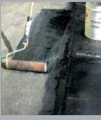
ACRYBASE S es un promotor de adhesión de base solvente para productos acrílicos o similares. Normalmente se utiliza como imprimante sobre membranas bituminosas y superficies metálicas para prepararlas para la adhesión de sistemas impermeabilizantes acrílicos o acrílico cementicio como Acryroof Plus y Dermacem.
