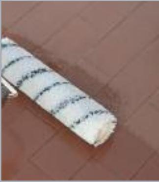
*Impermeabilizante poliuretánico bicomponente transparente para terrazas, balcones y duchas*
