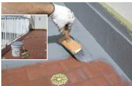
**1. APLICACIÓN DE IMPRIMANTE MULTIFIXO 100 SOBRE BALCÓN PAVIMENTADO**
