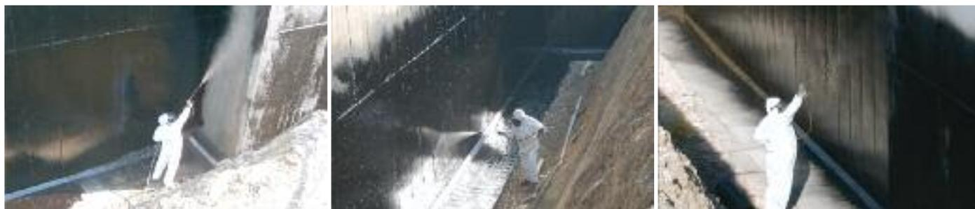
**DERMARUBBER S/P:** APLICACIÓN CON AIRLESS SOBRE MURO DE CIMENTACIÓN
