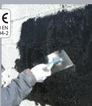
DERMARUBBER S es una pasta impermeabilizante, elastomérica, fibrorreforzada formada por betún en solución, con macromoléculas especiales que hacen que el producto seco sea impermeable y especialmente elástico.
